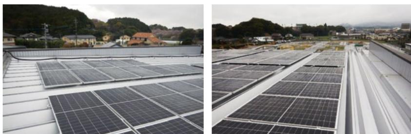
校舎と合宿生用の学校寮の屋根上に約95kWの太陽光発電設備を設置
